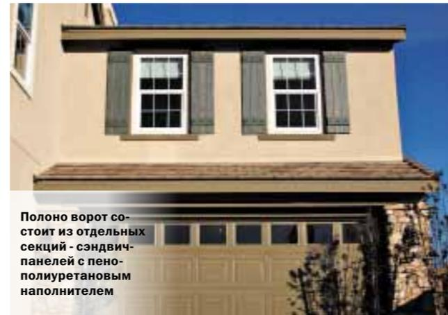
Полоно ворот состоит из отдельных секций - сэндвич-панелей с пенополиуретановым наполнителем
